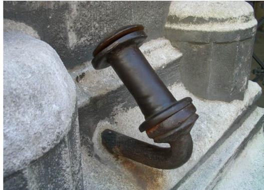
ursprünglich ist es ein relik aus der bauzeit des turms, die spule einer seilwinde.
